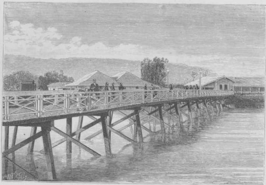
Brug over de Atjeh-rivier.
