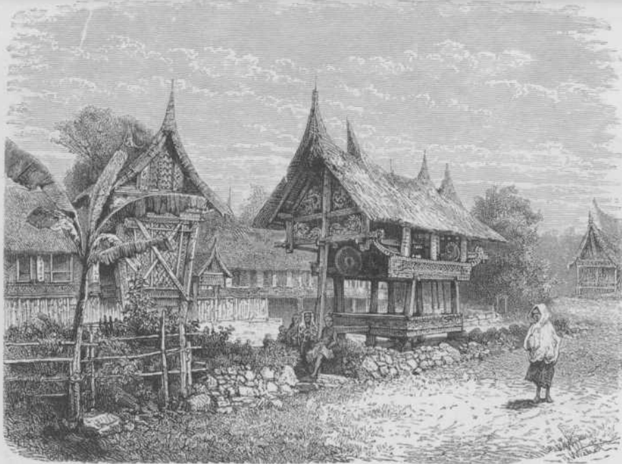
Huis met rijstschuur en taboehuisje te Alahan pandjang. (Maison avec grenier à riz.)
