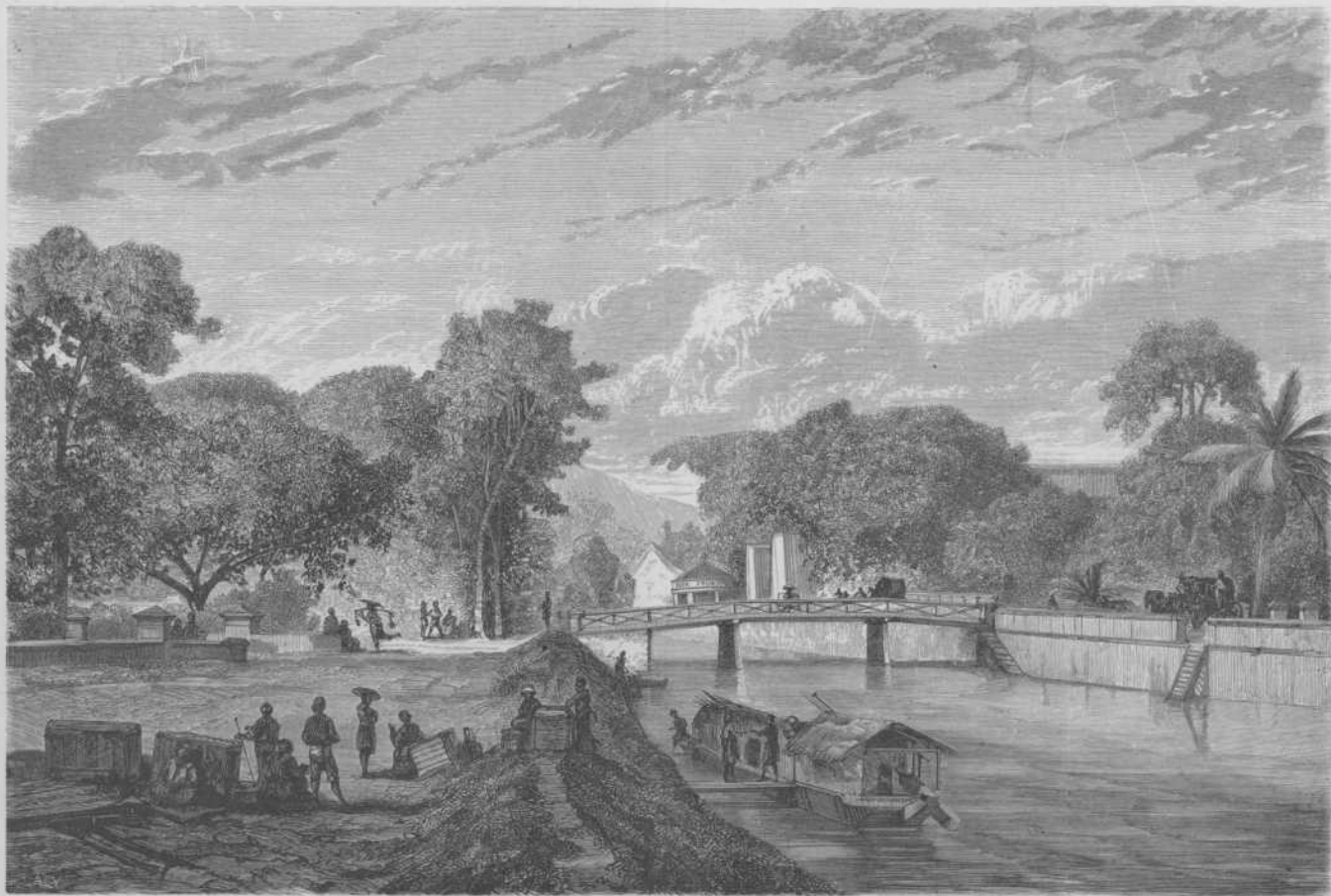
Gezicht in Batavia (de nieuwe stad). (Batavia: ville nouvelle.)
