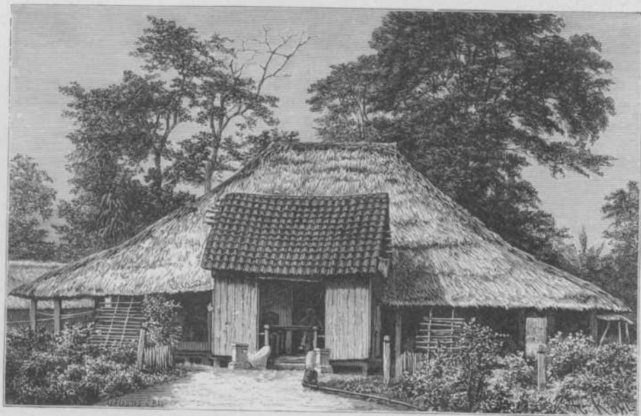
Controleurswoning te Mocara Laboe. (Habitation du contrôleur à Mocara-Laboe.)
